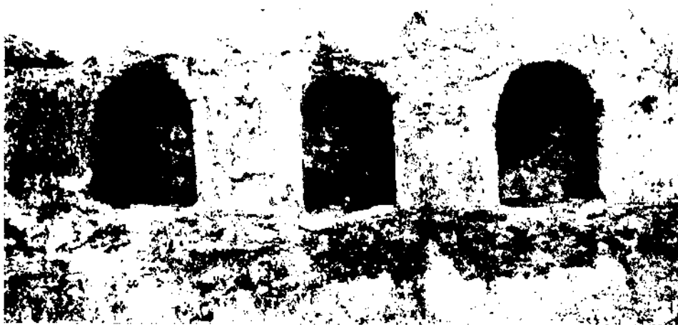
16.- Detall de les fornícules del mur de tramuntana del caldarium.
