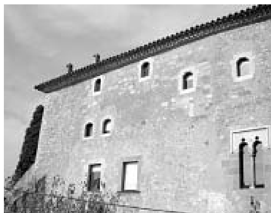
Façana meridional del castell-palau de Sant Mori.
