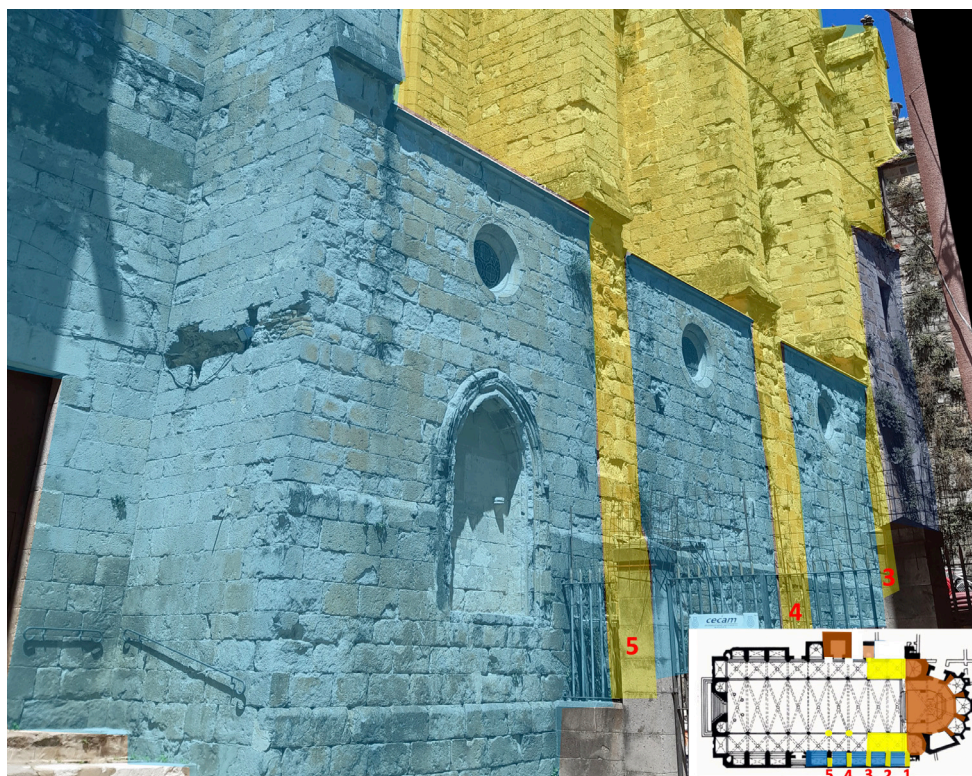
IMAGEN 9 · Muro de mediodía de Santa Maria de Castelló d'Empúries, con los contrafuertes enrasados y planta. © del autor.
